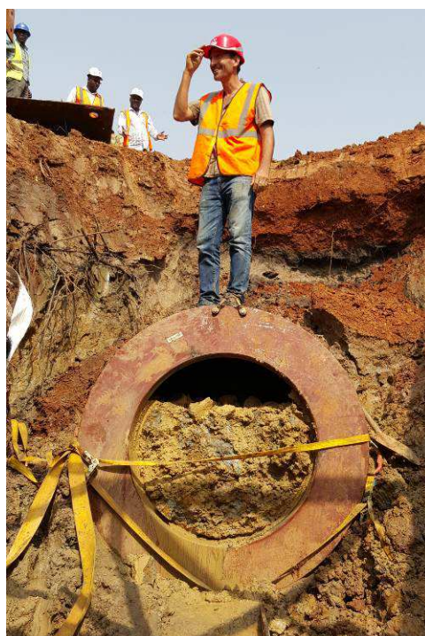
Les 3 tronçons de 7 m de tubes acier sont en place (21 m) et sont prêts à être vidés pour y installer les tuyaux finaux de Ø 1 200 mm.
