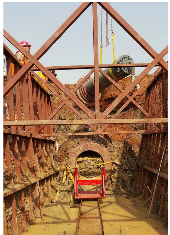
Une longueur de 7m de tube acier a été tapée en bridant la vitesse d'avance aux alentours des 11 m/ h. Le TR 565 est ensuite retiré.
