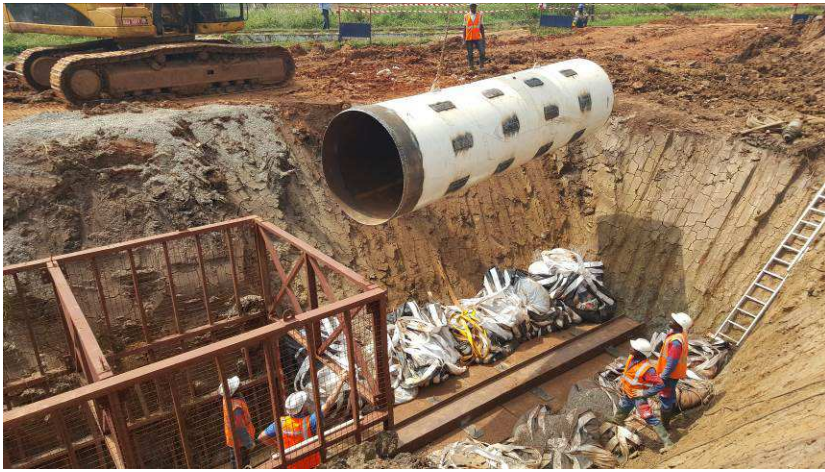
Le premier tube acier Ø 1 500 mm est descendu dans la fouille.
