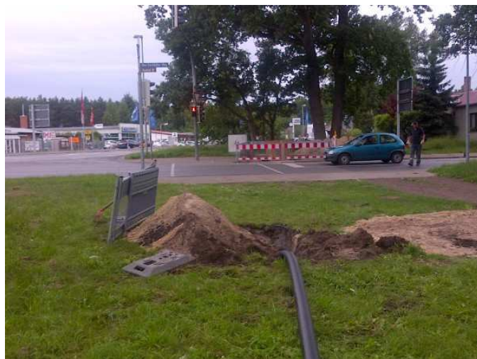
Le tuyau PEHD \varnothing 125 mm a été tiré sous cette route sur plus de 40 mètres de long.
