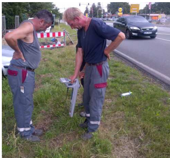
La tête de forage est repérée avec exactitude tout au long du forage du trou pilote.
