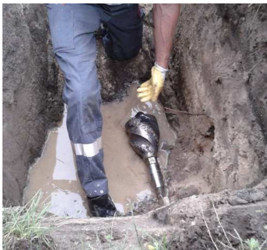
L'alésoir DE 160 mm est monté. L'introduction du fourreau peut commencer.
