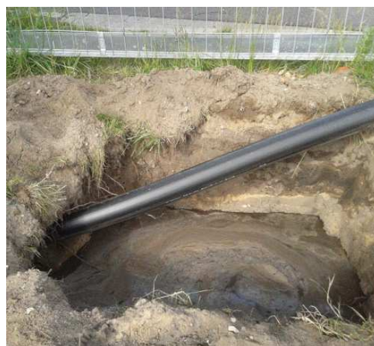
Le tuyau PEHD \varnothing 125 mm est introduit. La boue de forage avec le sable rejetés dans la fouille d'arrivée.
