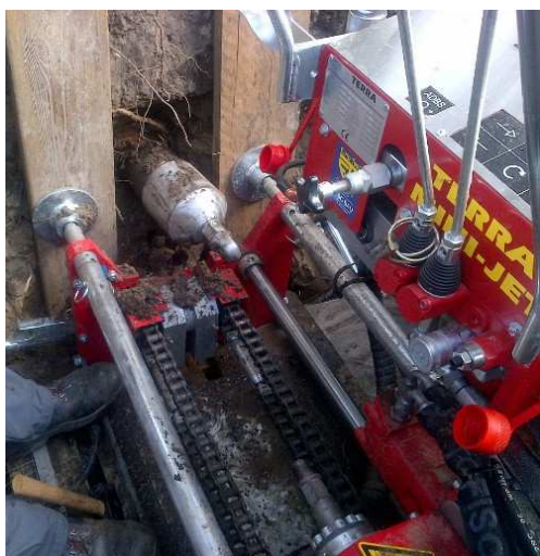
Le tuyau est introduit, le forage est terminé.
