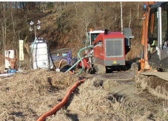
La TERRA-JET 8522 S pendant le forage du trou pilote.
