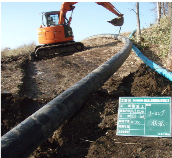
Le tuyau PEHD de DE 355 mm est introduit.
