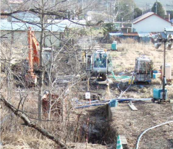
Vue sur la fouille de départ du forage long de 170 mètres.
