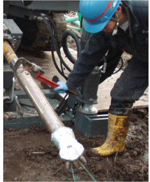
La tête de forage à 3 doigts est mise en place car le trou pilote traverse des sols durs.
