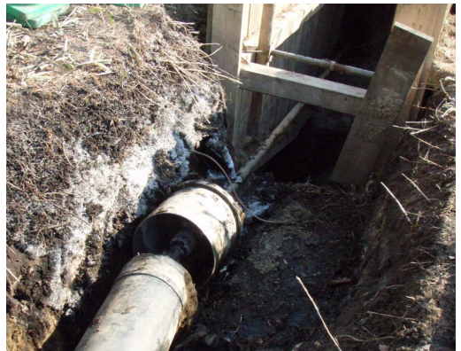
Le tuyau PEHD de DE 355 mm est monté sur l'alésieur de 520 mm.
