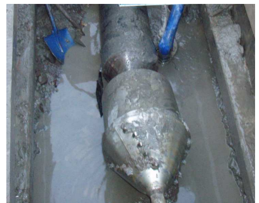
Après 170 m, l'alésieur de 520 mm et le fourreau PEHD DE 355 mm rejoint la TERRA-JET 8522 S. Le forage est terminé avec succès.
