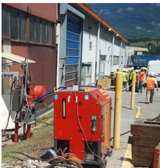
Vue sur l'un des tronçons à renouveler.
