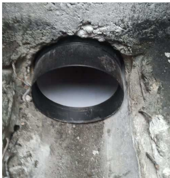
Le nouveau tronçon de tuyaux est posé.
